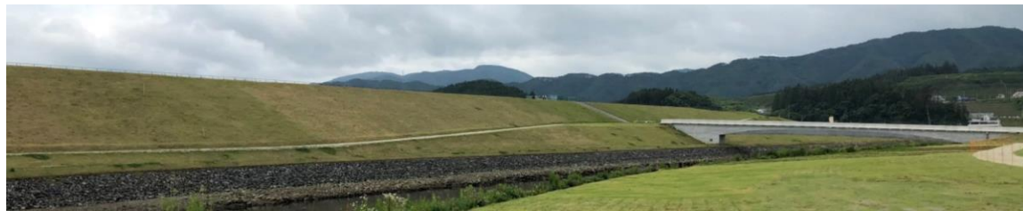
海岸堤防への背面盛土
